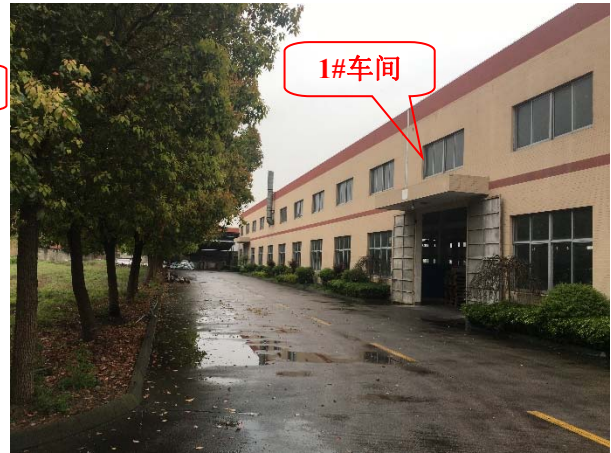
图 8-4 电子加速器机房拟建场址北侧
